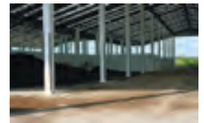
Un edificio abandonado en la estación de transferencia de residuos de On Nut que podría ser utilizado como centro de compostaje centralizado
